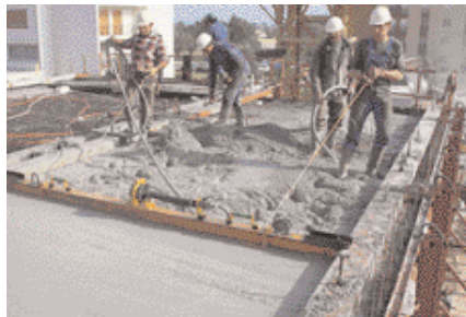
BETONNAGE ET FINITIONS GROS ŒUVRE
