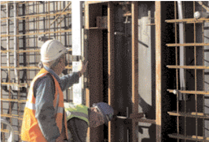
POSE FERRAILAGE ET ÉLECTRICITÉ
